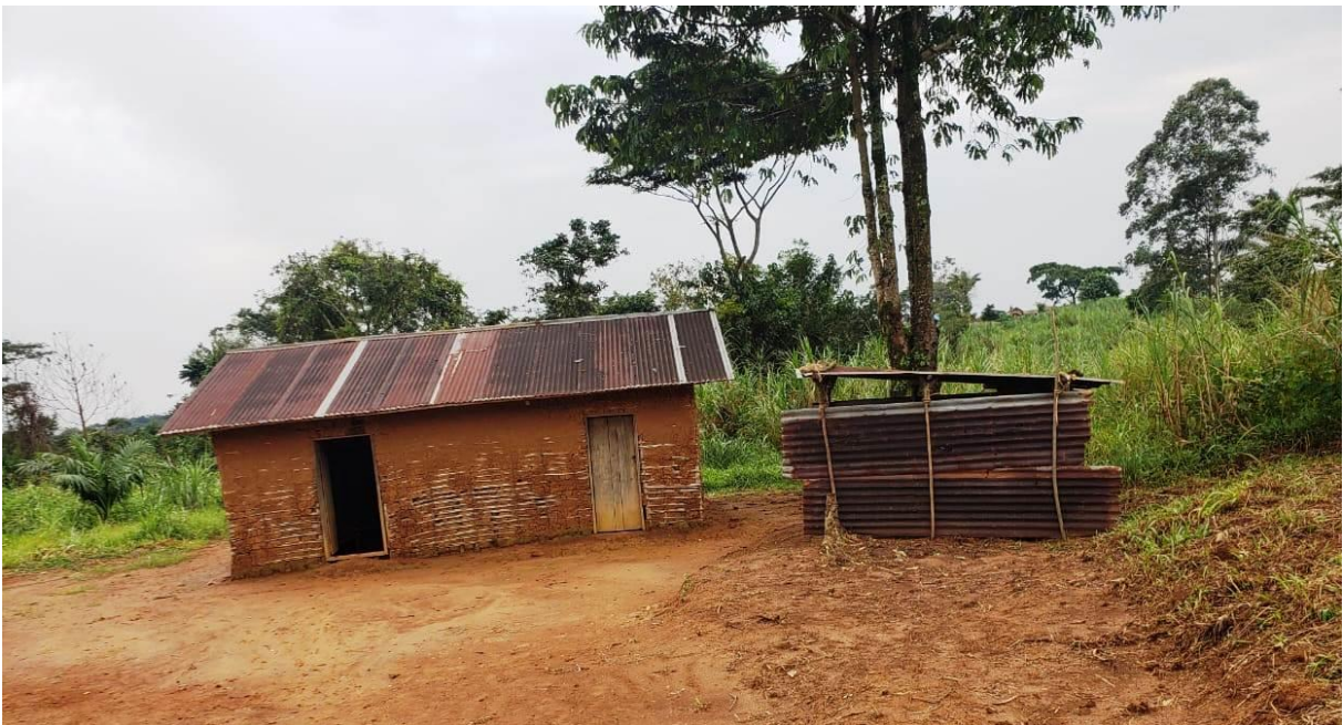
(L'état actuel du poste de santé de MASEKESEKE)
